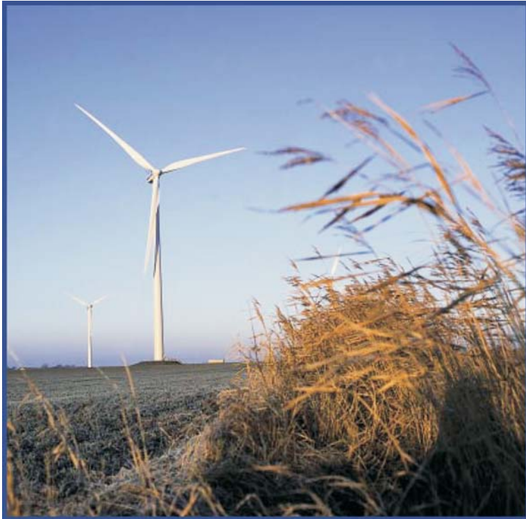
Vestas V90 – 3.0 MW
