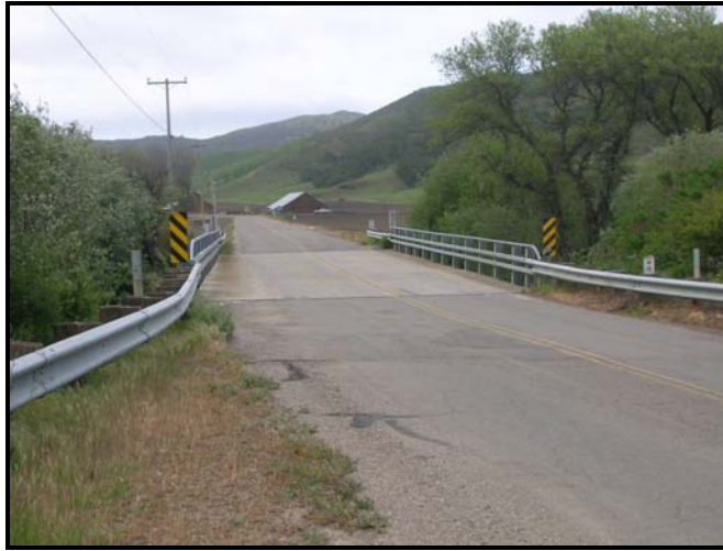
Jalama Rd. Bridge at Salsipuedes Creek (No. 51C-014)
