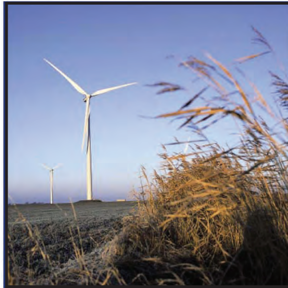
Vestas - V90 - 3.0 MW
